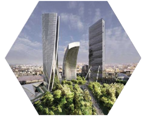
Milano, Italia CITYLIFE SPA Progettazione e posa dello schermo piano e delle cana- lette schermanti G-iron
