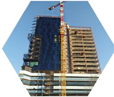
Genova e Milano, Italia SIEMENS SPA Installazione del sistema schermante G-iron all'inter- no del locale tecnico
