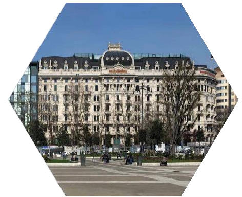
Milano, Italia HOTEL EXCELSIOR GALLIA Schermatura dei locali tecni- ci a protezione della sala conferenza
