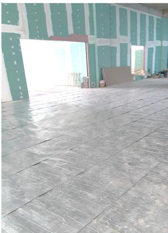
Fig. 2 Posa sistema G-iron ArmoFlex® a pavimento
