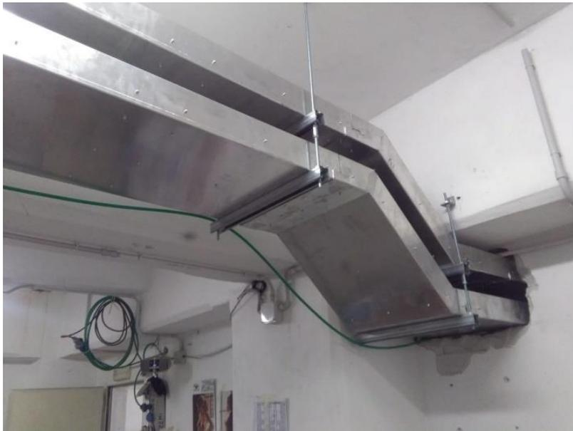
Fig. 3 Canala G-iron staffata su intradosso: dettaglio di cambio di livello
